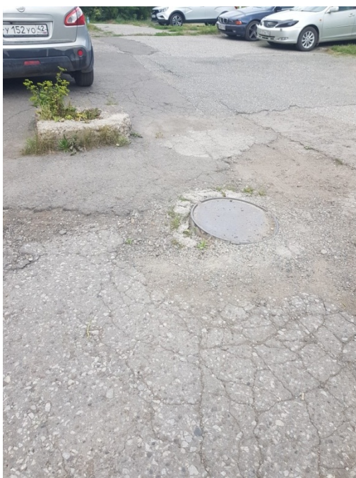
Рис.№ 5. Нарушено высотное положение крышки колодца.
